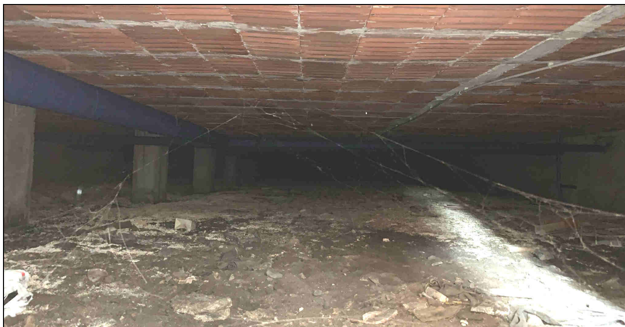
Veduta del vano isolante presente al di sotto del solaio laterocemento del piano terreno: pilastri centrali
