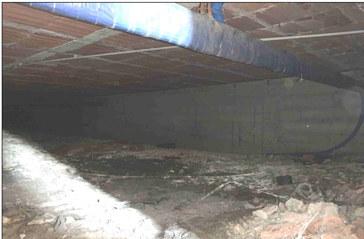
Veduta del vano isolante presente al di sotto del solaio laterocemento del piano terreno: muro perimetrale
